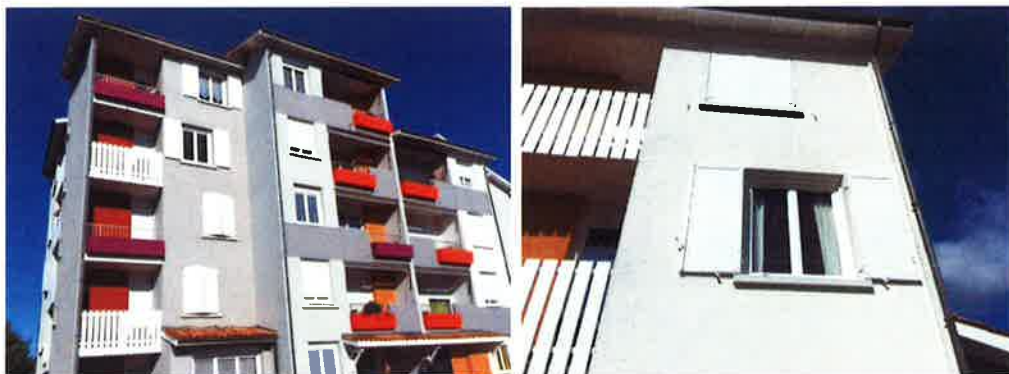
Chantier le Parc à Bruges (33)
